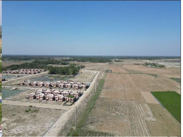
Photo: Dhulasar Rehabilitation (Kalapara)
