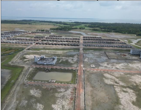
Photo: Dhulasar Rehabilitation (Kalapara)
